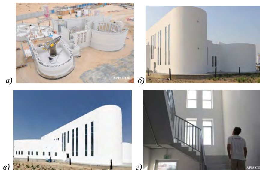
Рис. 6.27. Дом в Дубае, напечатанный на 3D-принтере прямо на стройплощадке : а) процесс печати здания 3D-принтером, б), в) фасады уже напечатанного здания, г) внутренне пространство напечатанного здания. (Источник: Forbes)
