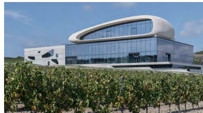
Рис. 6.37. Винодельня Côte Rocheuse («Скалистый берег»), которую построили в селе Варваровка рядом с г. Анапа Краснодарского края в конце 2020 г. Объект полностью спроектирован в BIM. Архитектор — Александр Балабин, основатель компании «Северин Проект» (Источник: РБК)
