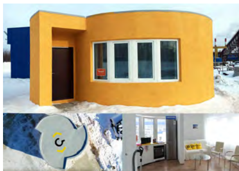
Рис. 6.26. Дом, напечатанный на 3D-принтере
