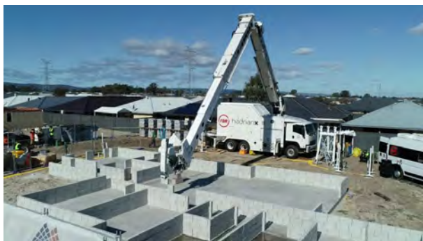
Рис. 6.16. Австралийский робот-каменщик Nadrian X. (Источник: building-tech)
