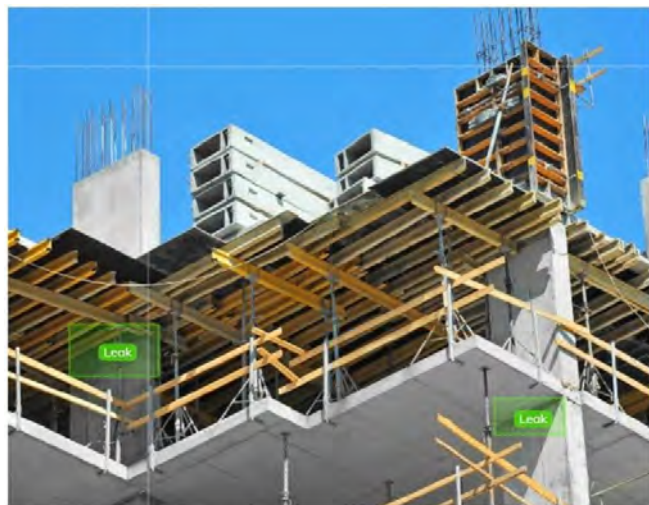
Рис. 6.12. Обнаружение дефектов в бетоне с помощью нейросети
