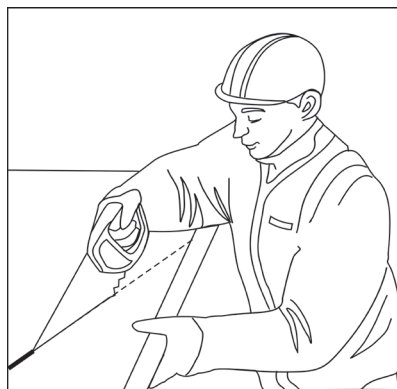
Рисунок 6.1 – Раскрой теплоизоляционных плит с использованием ножовки ручной
