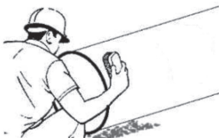
Рисунок Б.1 – Очистка поверхности трубы
