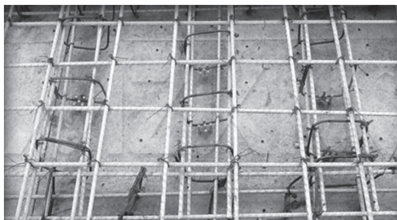
Рисунок 4.3 – Объемный каркас из АНК
