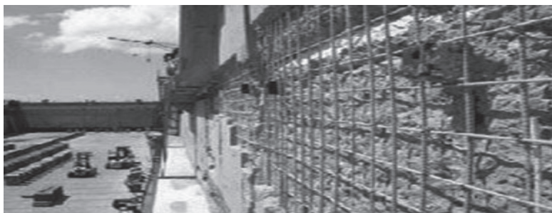
Рисунок 8.11 – Сетка из АНК под покрытие стены крепления котлована
