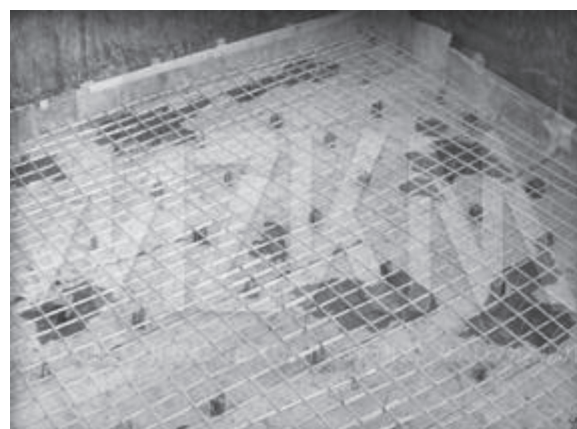
Рисунок 8.3 – Применение АНК для армирования фундаментной плиты 1)
