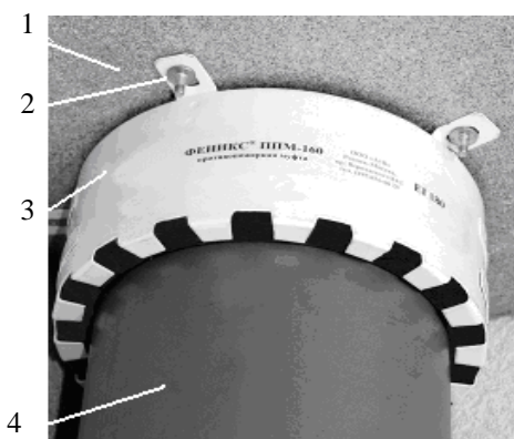
1 – перекрытие; 2 – крепление; 3 – муфта; 4 – труба
